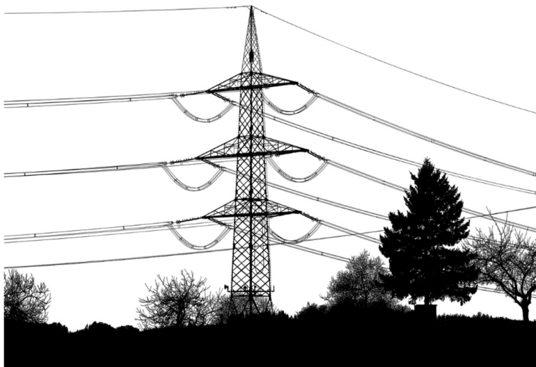
traliccio della corrente elettrica
