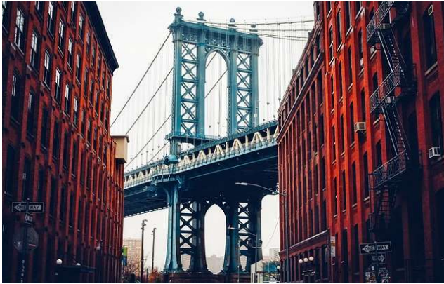
ponte con strutture triangolari
